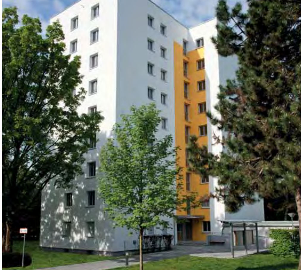
Das Punkthaus in der Untermenzinger Straße 80 nach der Sanierung
